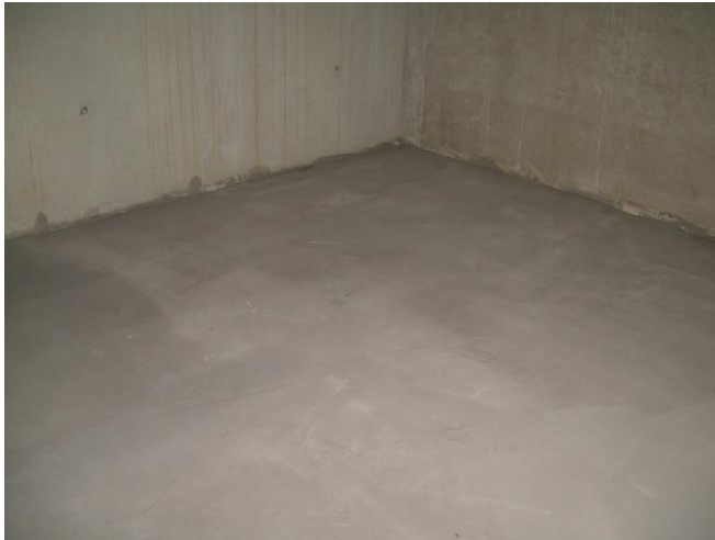
glatter, geeigneter Untergrund aus Betonestrich
