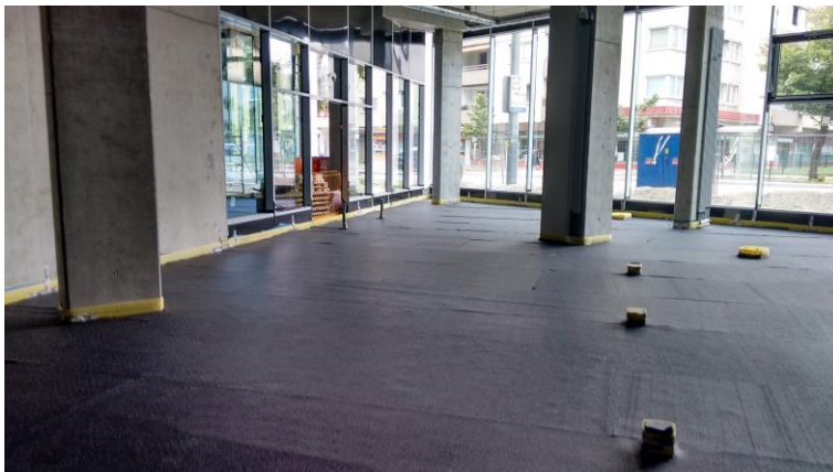
Verlegung der Elastikschicht im ganzen Raum
