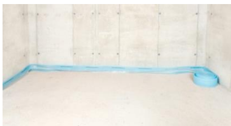
Verlegung von Randdämmstreifen
