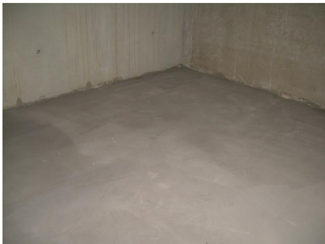
glatter, geeigneter Untergrund aus Betonestrich
