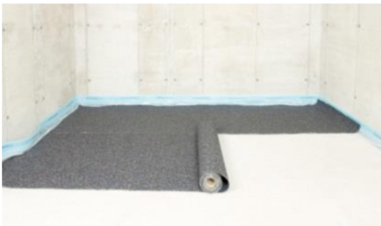
Verlegung der einzelnen Bahnen Stoß an Stoß
