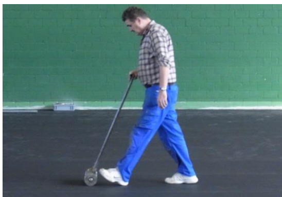
Abrollen des Belages mit einer Anpresswalze
