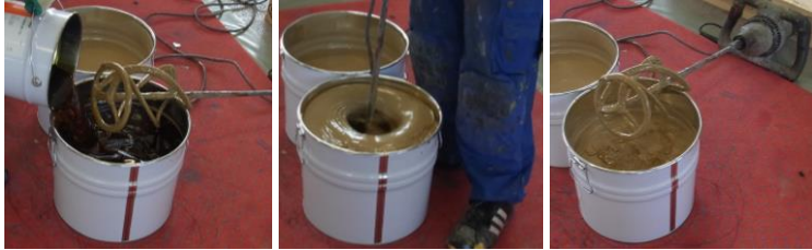
Anrühren des 2-Komponenten PU-Klebers
