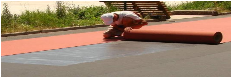
Ausrollen des Oberflächenbelages auf die Elastikschicht
