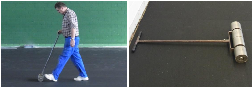
Abrollen des Belages mit einer Anpresswalze
