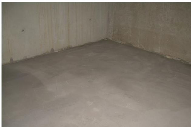
glatter, geeigneter Untergrund aus Betonestrich
