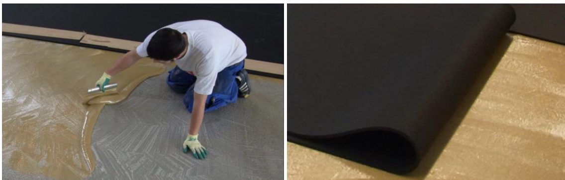
Kleberauftrag auf den sauberen Untergrund; ausrollen der Bahnen in das Kleberbett
