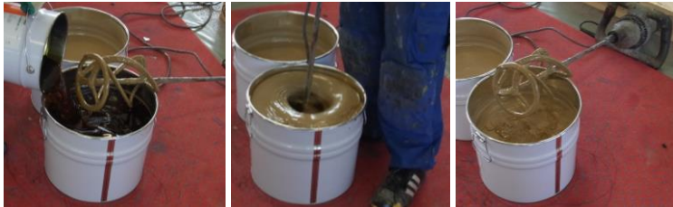
Anrühren des 2-Komponenten PU-Klebers
