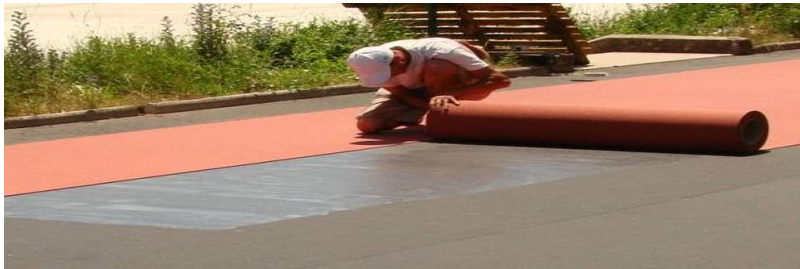
Ausrollen des Oberflächenbelages auf die Elastikschicht
