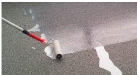
Abb. 3 und 4: Auftragen der Versiegelung
