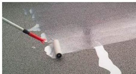
Abb. 3 und 4: Auftragen der Versiegelung
