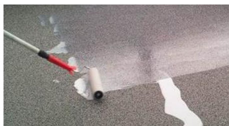
Abb. 3 und 4: Auftragen der Versiegelung
