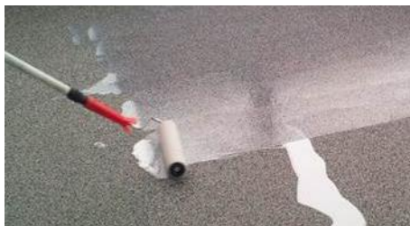
Abb. 3 und 4: Auftragen der Versiegelung
